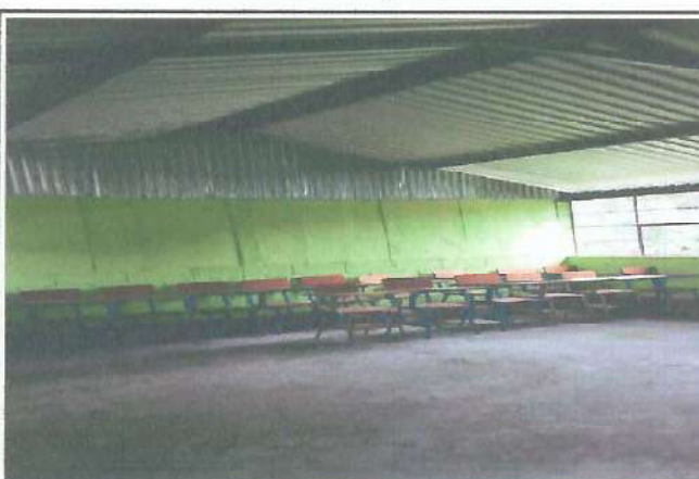
Foto 4: Reparación de paredes de aulas y pintura de interior y exterior
