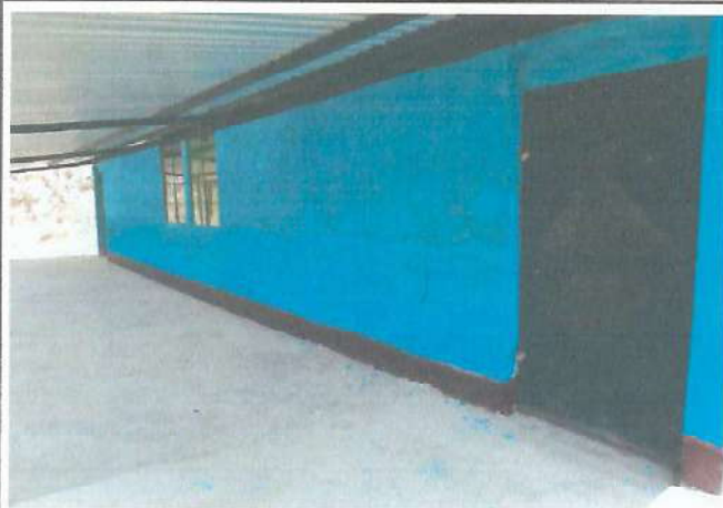
Foto 1: Reparación de paredes de aulas y Pintura de interior y exterior
