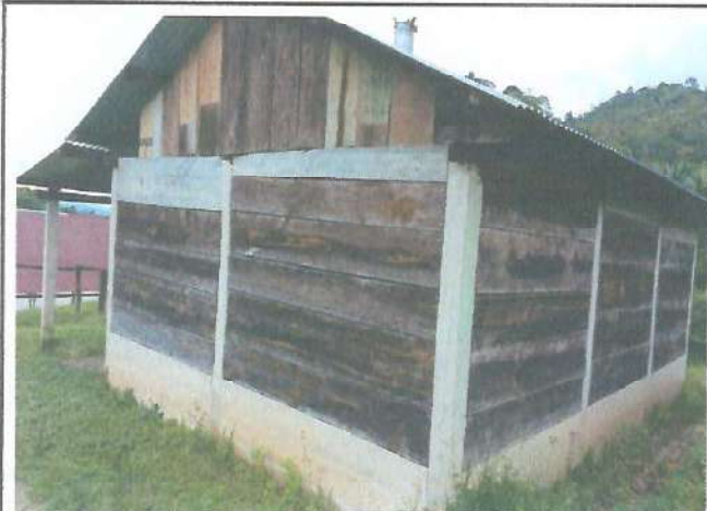
Foto 1: Reparación de la cocina con estructura metálica y lámina troquelada calibre 26
