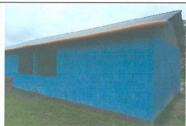
Foto 3: Reparación de paredes de aulas y Pintura de interior y exterior
