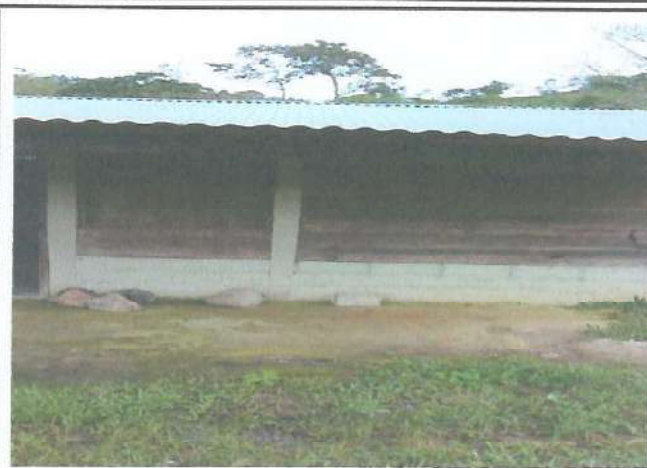
Foto 2: Reparación de la cocina con estructura metálica y lámina troquelada calibre 26
