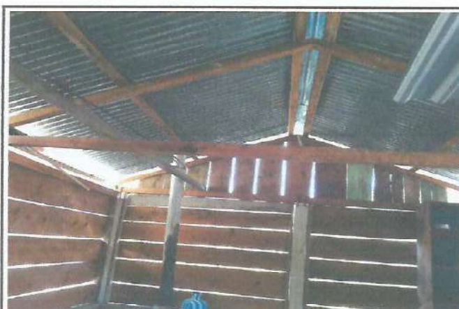
Foto 4: Reparación de la cocina con estructura metálica y lámina troquelada calibre 26
