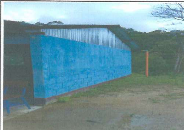
Foto 2: Reparación de paredes de aulas y Pintura de interior y exterior
