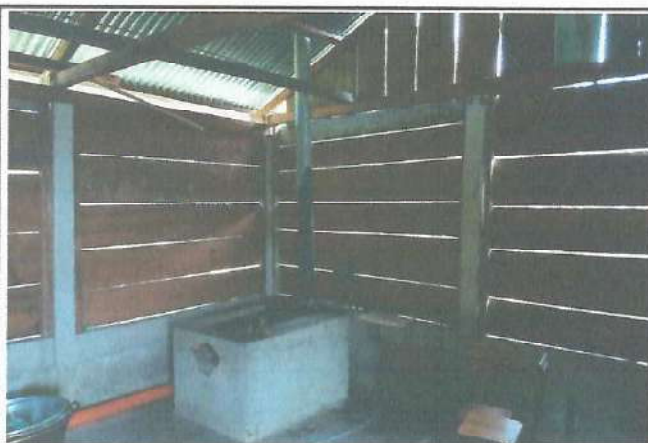
Foto 3: Reparación de la cocina con estructura metálica y lámina troquelada calibre 26
